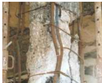
Figura 8: Deformime plastike dhe prishja e shufrave
