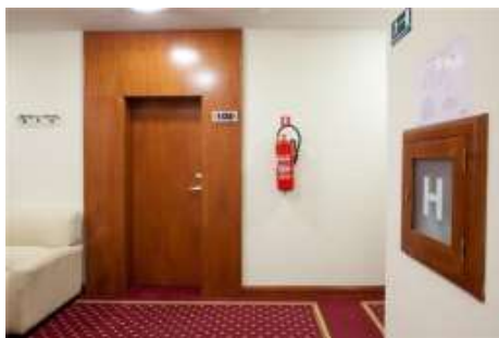
Figura 25. Aparat për zjarrfikje dhe hidratant në dhomën e hotelit ( http://www.travelino.hr )
