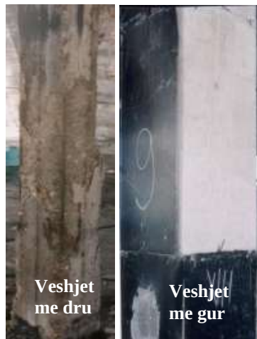
Fig. 20. Ndikimi i llojit të llojit të shtresave dekorative në shkallën e dëmtimit nga zjarri të shtyllave të betonit
