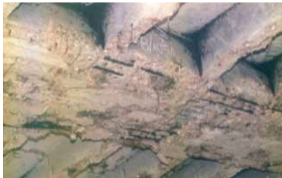
Figura 7. Pamja karakteristike e trarit longitudinal pas zjarrit
