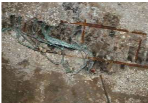
Fig. 17. Mbinxehja e thellë lokale e betonit dhe shufrat e armaturës të deformuara për shkak të instalimeve elektrike brenda prerjes së tërthortë (a - trari, b - pllaka)
