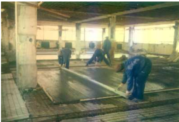
Figura 28. Betonimi i pllakës së re
