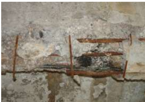
Fig. 17. Mbinxehja e thellë lokale e betonit dhe shufrat e armaturës të deformuara për shkak të instalimeve elektrike brenda prerjes së tërthortë (a - trari, b - pllaka)
