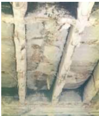
Figura 8 dhe 9. Pamja karakteristike e strukturës së tabanit pas zjarrit
