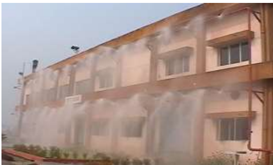
Figura 30. Sistemi i ujëmblytësve “drencher”
