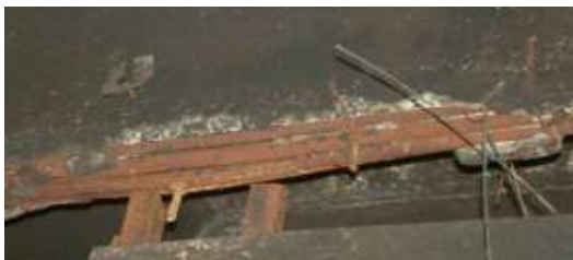
Fig. 16. Dëmet karakteristike të shufrave të armuara jo në mënyrë të duhur për shkak të zjarrit
