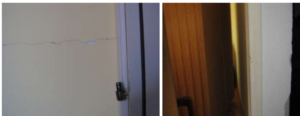
Figura 11. Plasaritja e murit ndarës dhe rrotullimi i derës së dhomës së gjumit, shkaktuar nga shpërthimi i rrymës së ajrit
