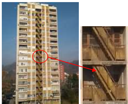
Figura 45. Pasojat e mirëmbajtjes së dobët të shkallëve të jashtme për shpëtimin nga zjarri (ndërtesa me shumë kate Tuzla, B&H)
