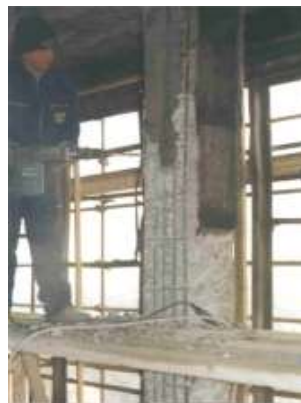
Figura 10 dhe 11. Heqja e shtresës së dëmtuar të betonit nga shtylla
