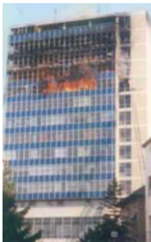
Fig. 18. Përhapja e zjarrit në të dy drejtimet vertikale [9]
