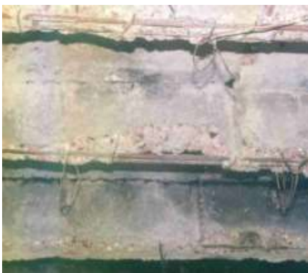
Fig. 15. Dëmet tipike të sistemit të dyshemesë së tabanit për shkak të zjarrit
