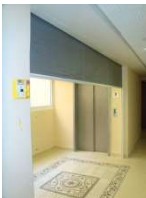
Figura 13. Perdet e zjarrit për ashensorë ( http://www.metalpress.co.il/en/product/fire-curtains-for-elevators.aspx )
