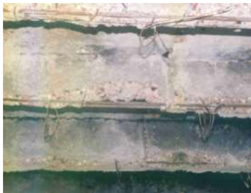
Figura 8 dhe 9. Pamja karakteristike e strukturës së tabanit pas zjarrit
