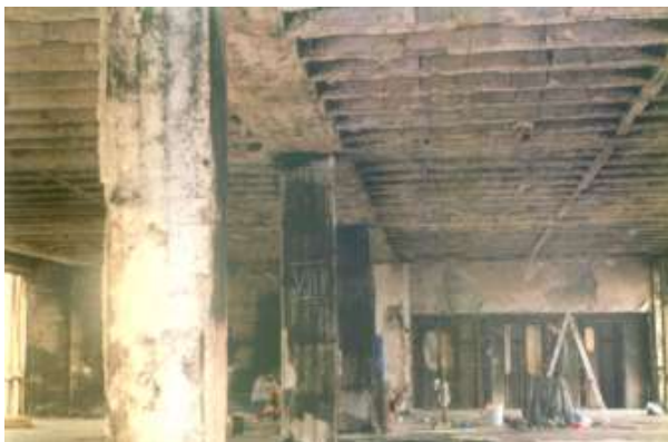
Figura 5. Pamja e strukturës së dëmtuar në katin e 8-të pas zjarrit dhe pastrimit
