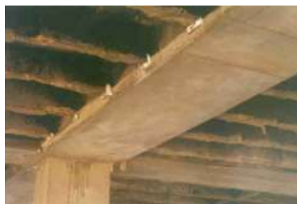
Figura 20. Pamja e mbulesës së re mbrojtëse në pjesën e poshtme të trarit
