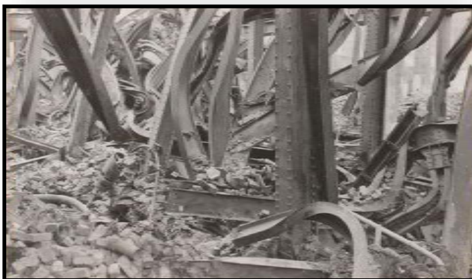
Slika 1 - Primjeri posledica požara čeličnih konstrukcija
