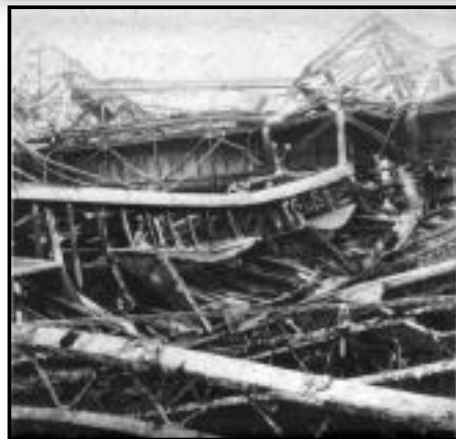
Slika 1 - Primjeri posledica požara čeličnih konstrukcija
