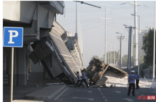
Сл. 1. Мостовски конструкции срушени заради конструктивна нерегуларност, земјотрес Кина 2008 год.
