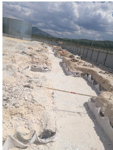
Слика 2. Изведба на темелниот ископ
