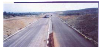
Инженеринг при конструкција на автопат
