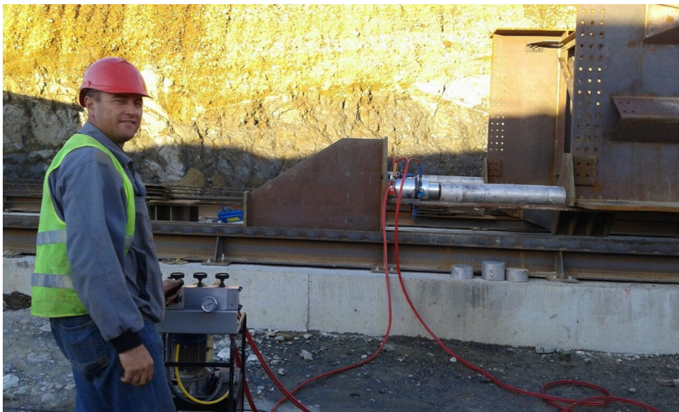
Сл. 12. Уредот за туркање со хидраулични преси
