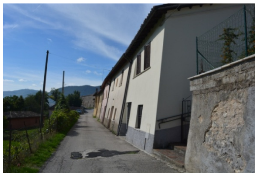
Сл. 5. Типични ѕидани куќи од приземје и еден спрат со кос фасаден ѕид (фотографијата е направена по земјотресот од 24 август)
