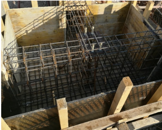
Слика 5. Армирање на темелни греди
