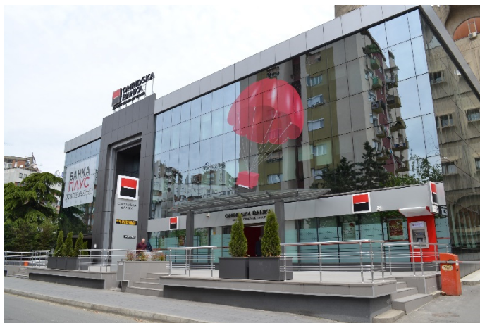
Слика 1. Денешен изглед на конструкцијата Деловен објект – Охридска Банка
