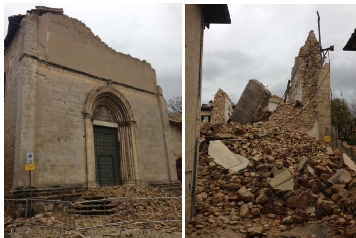
Сл. 23. Тотално рушење на дел од црковен храм во Норчија по настанот М6.5
