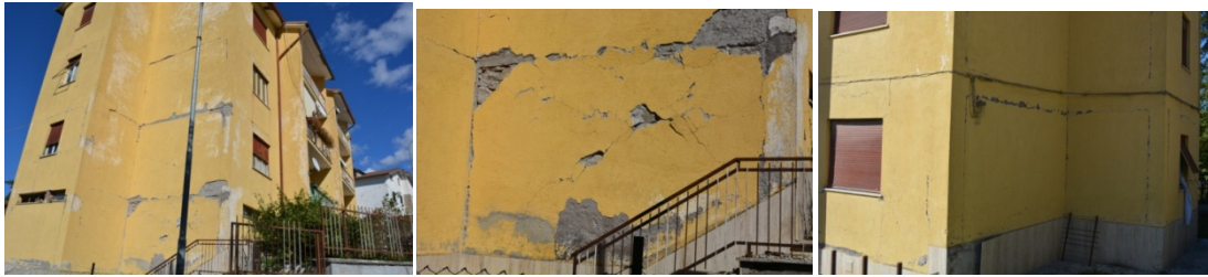
Сл. 6. Оштетување на четириспратна АБ рамка со исполна од шупла цигла од категорија D1
