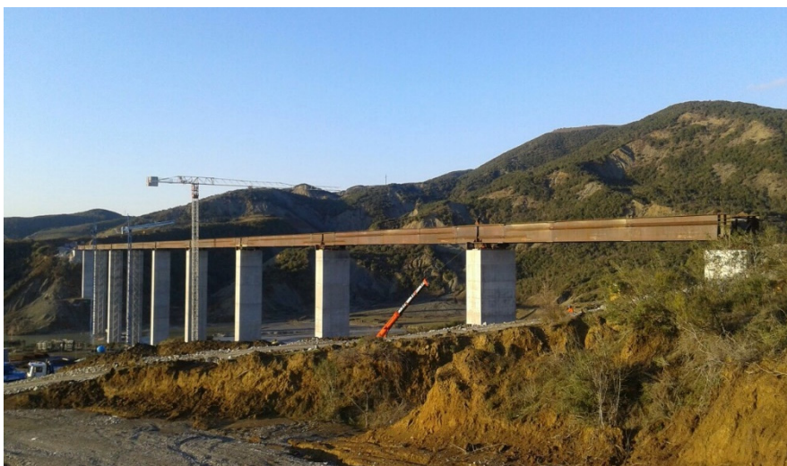
Сл. 2. Спрегнат мост бр. 04 - во фаза на градба
