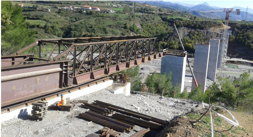
Сл. 13. Помошна челична конструкција - нос за лансирањето
