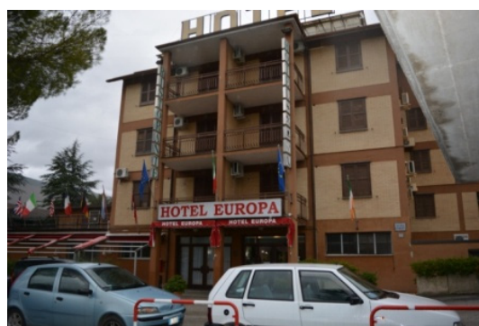
Сл. 10. Зграда без оштетувања по М6 и со оштетувања D1 по М6.6
