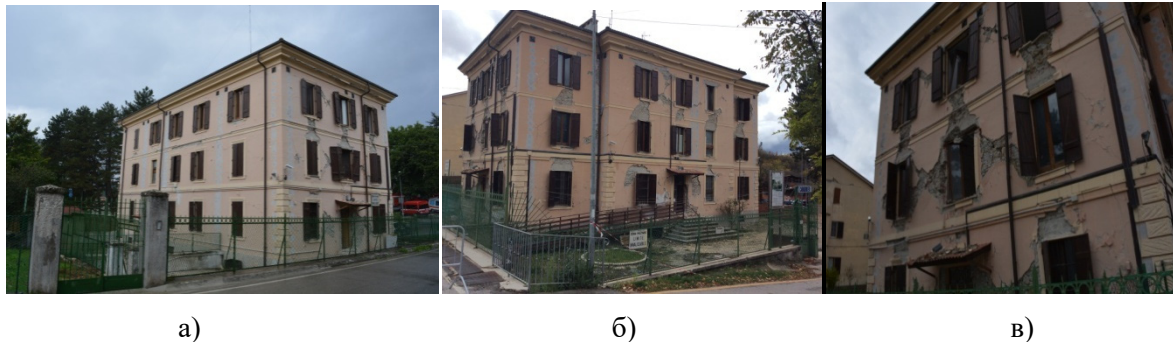
Сл. 8. Зајакната конструкција на ќошевите со челични траки
