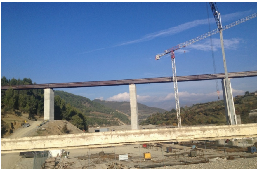
Сл. 6. Спрегнат мост бр. 12 - во фаза на градба
