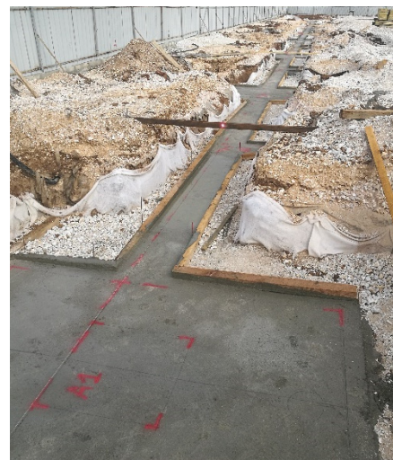
Слика 4. Означување на местоположба на темели и анкери
