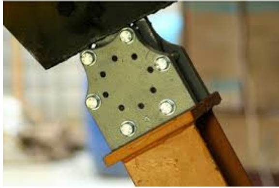
Сл. 2. Оловен дампер–Пингвин вибрационен дампер (PVD)
