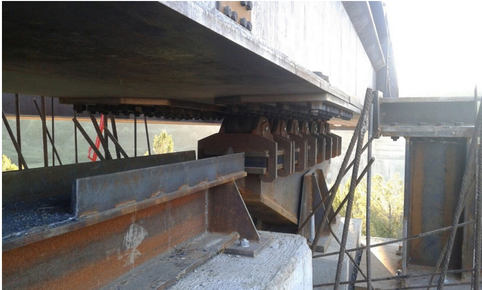
Сл. 11. Монтажа на челичната контрукција - туркање
