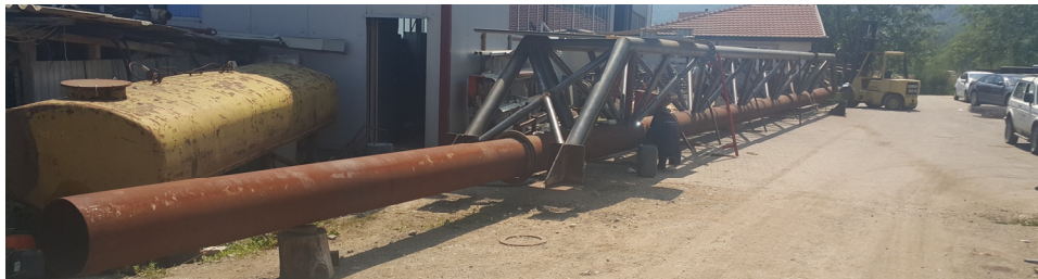
Сл. 6. Пробно склопување на конструкцијата во производство
