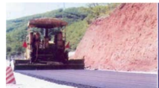
Инженеринг при конструкција на регионален пат
