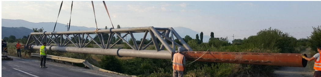
Сл. 7. Монтажа на конструкцијата
