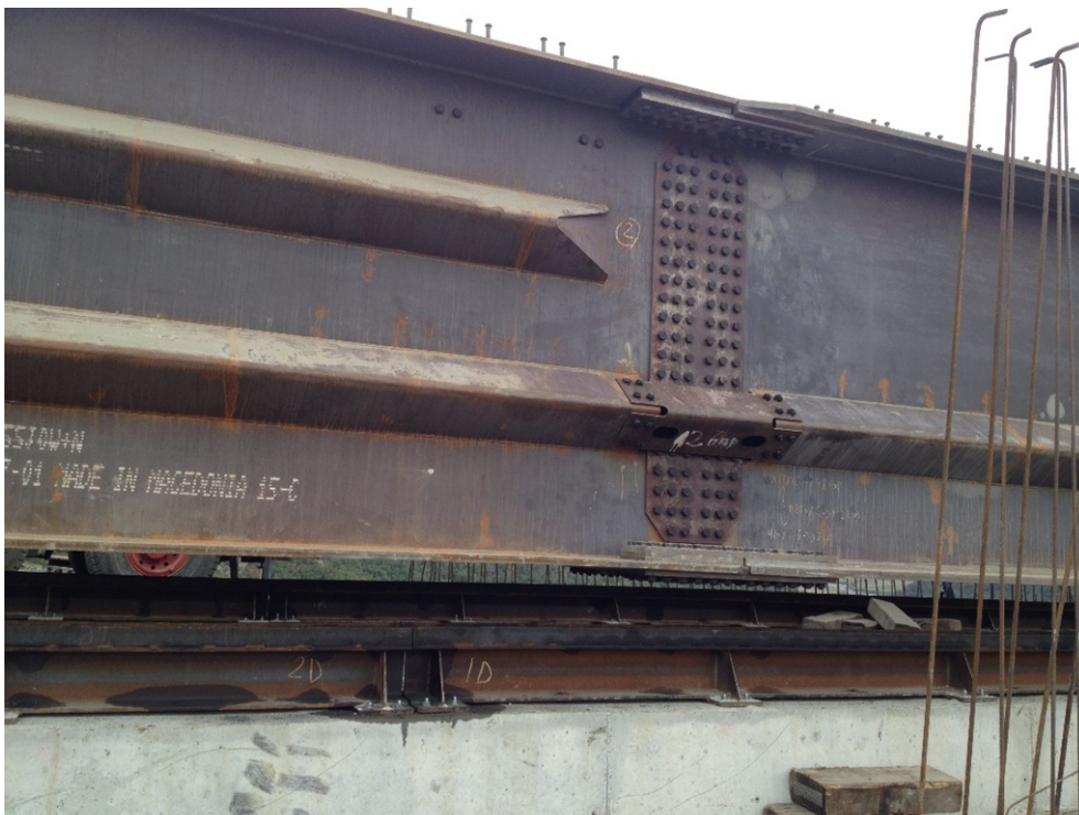
Сл. 10. Монтажа на челичната конструкција
