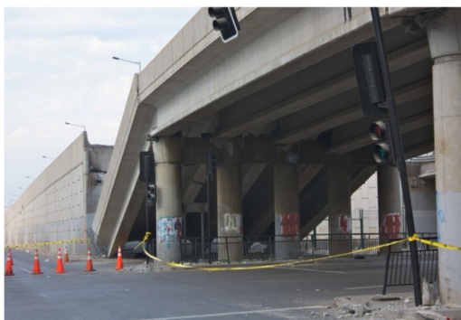
Сл. 2. Мостовски конструкции срушени заради конструктивна нерегуларност, земјотрес Кина 2008 год.
