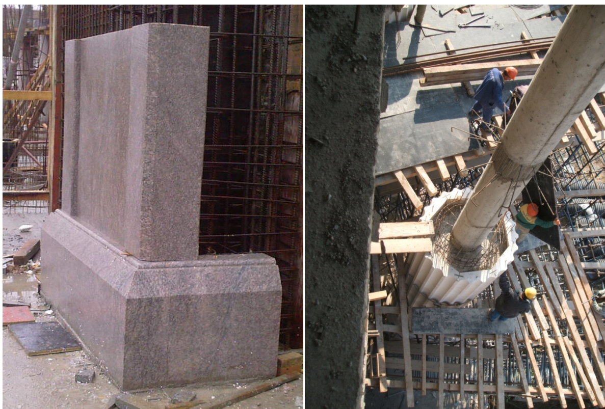
Слика 4а, 4б: Користење на фасадните облоги од камен како оплата
