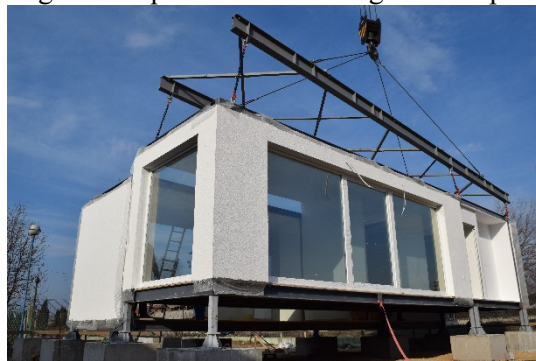
Fig. 23. On-site assembly
