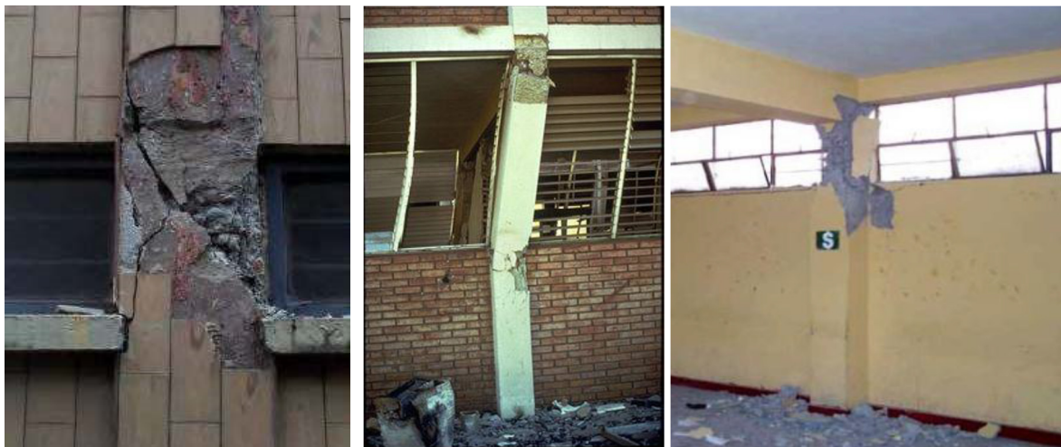
Сл.12. Формирање на краток столб со механизам на лом во столбовите поради влијанието на присуството на отворите во исполната од сидарија
