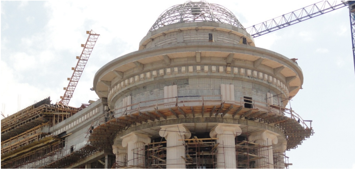
Слика 5: Користење на фасадните облоги како оплата
