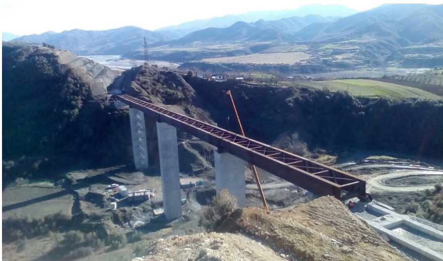
Сл. 4. Спрегнат мост бр. 07 - во фаза на градба
