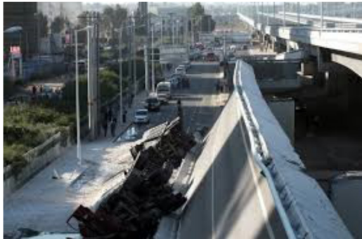
Сл. 1. Мостовски конструкции срушени заради конструктивна нерегуларност, земјотрес Кина 2008 год.
